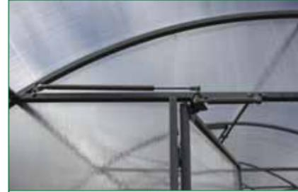
Термопривод открывает и закрывает дверь
